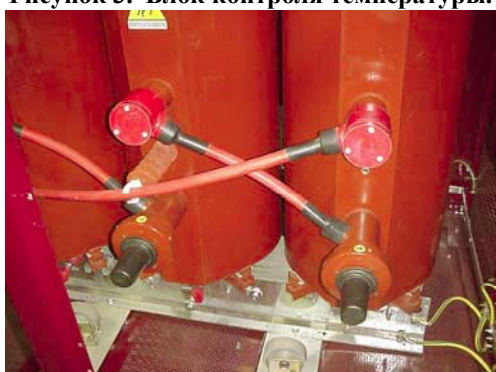
Рисунок 5. Соединители для присоединений высокого напряжения.
